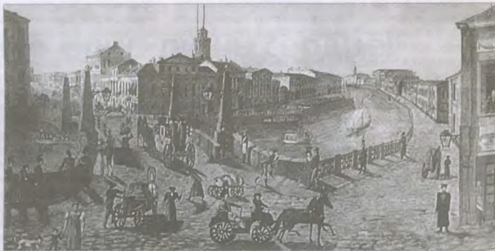
Санкт-Петербург. У Красного моста через Мойку.
